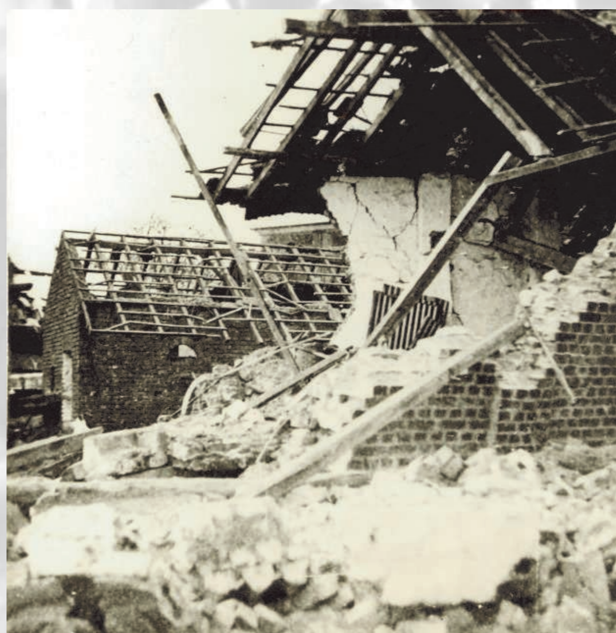
Ramachers Mühle in Wegberg, zerstörte Nebengebäude um 1945 Stadtarchiv Wegberg
