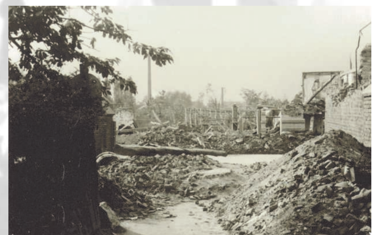
Wegberg, Ecke Birkenallee - Bahnhofstraße An dieser Stelle wurden mehrere Häuser völlig zerstört. Im Hintergrund links ist der Schornstein der Leinenweberei Billmann zu erkennen. um 1945 Stadtarchiv Wegberg
